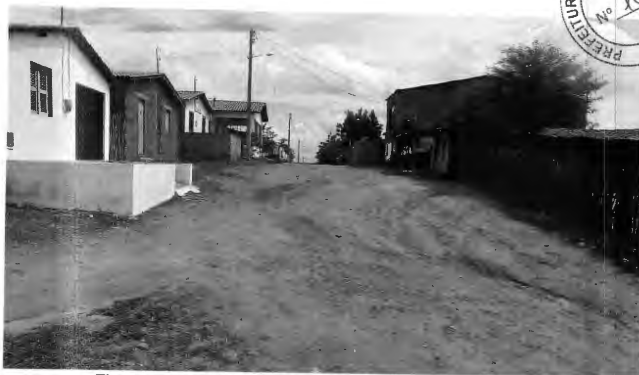
Figura 1 –Rua Bela Vista 005 – Estaca 00 no sentido Estaca 15+6
