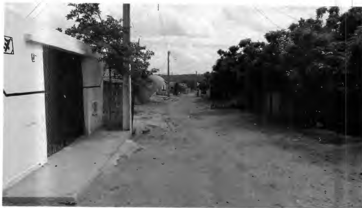
Figura 2 –Rua Bela Vista 005 – Estaca 06 no sentido Estaca 15+6
