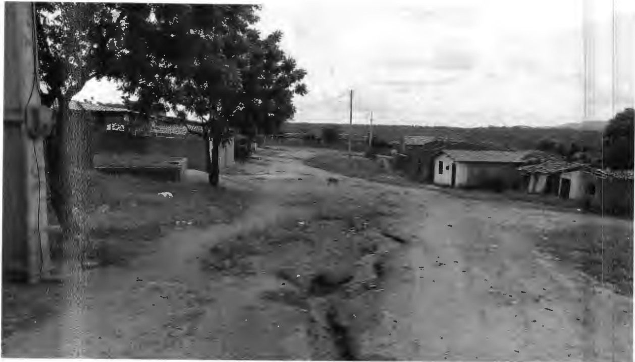
Figura 4 –Rua Bela Vista 005 – Estaca 12 no sentido Estaca 15+6
