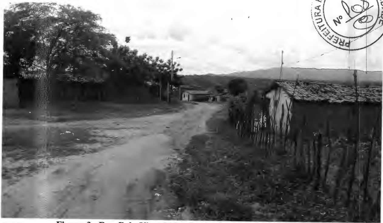
Figura 3 –Rua Bela Vista 005 – Estaca 09 no sentido Estaca 15+6
